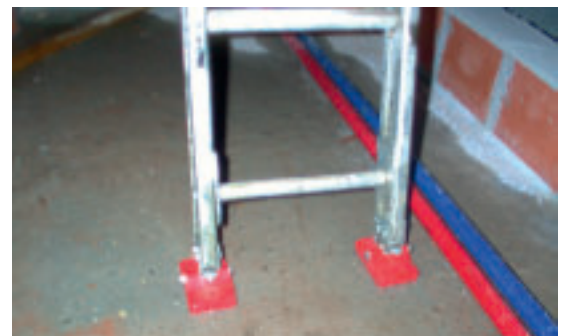
Figuur 12: Ladderschoenen geven een ladder meer stabiliteit
