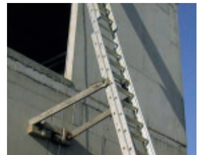
Figuur 1: Een bevestigingsmogelijkheid om te vermijden dat de ladder wegschuift
