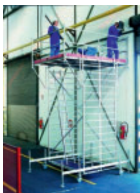
Figuur 21: Een voldoende basis voor de rolsteiger
