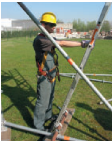
Figuur 6: Een tweede methode om de juiste hoek van de ladder te bepalen
